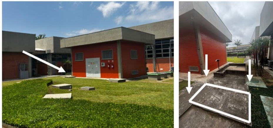
Figura 8 – Área disponível para instalação do gerador (GMG) e dos autotransformadores
